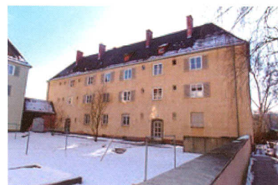
Das Haus vor dem Umbau.
